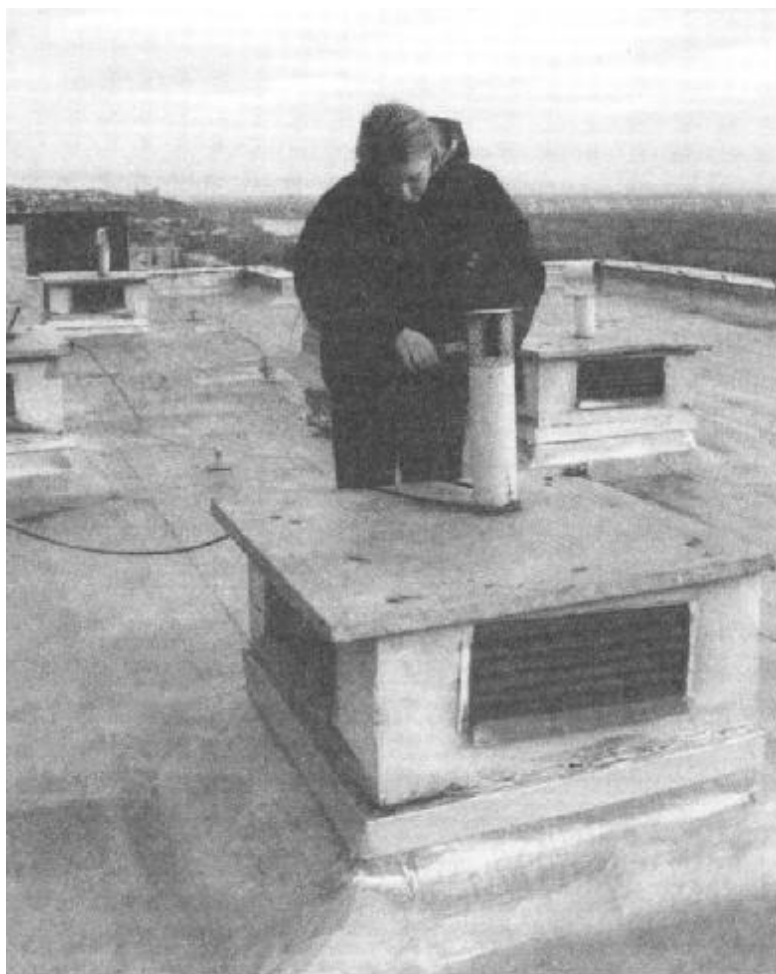
Obr. 2. Inštalácia pletiva na vetráky a komíniky panelového domu. Fig. 2. Installation of the wire netting on the vents of the prefab.
