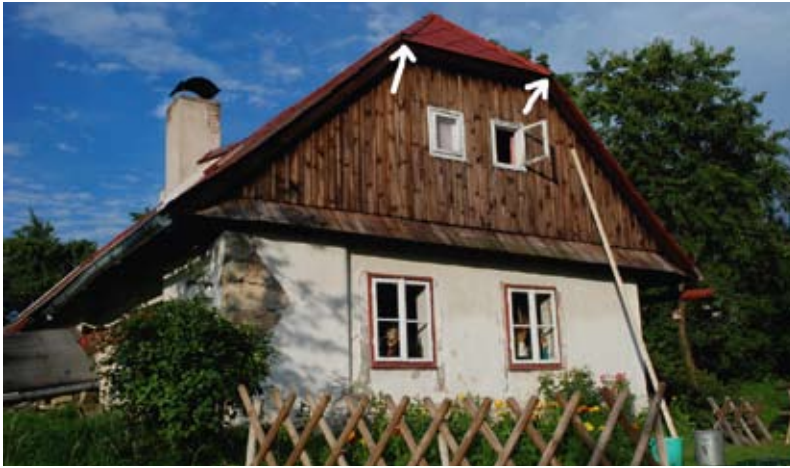
Obr. 1. Dům v Branišově, ve kterém byla nalezena mateřská kolonie netopýra pestrého ( Vespertilio murinus ). Šipkami jsou označeny výletové otvory. Foto V. Lemberk.
