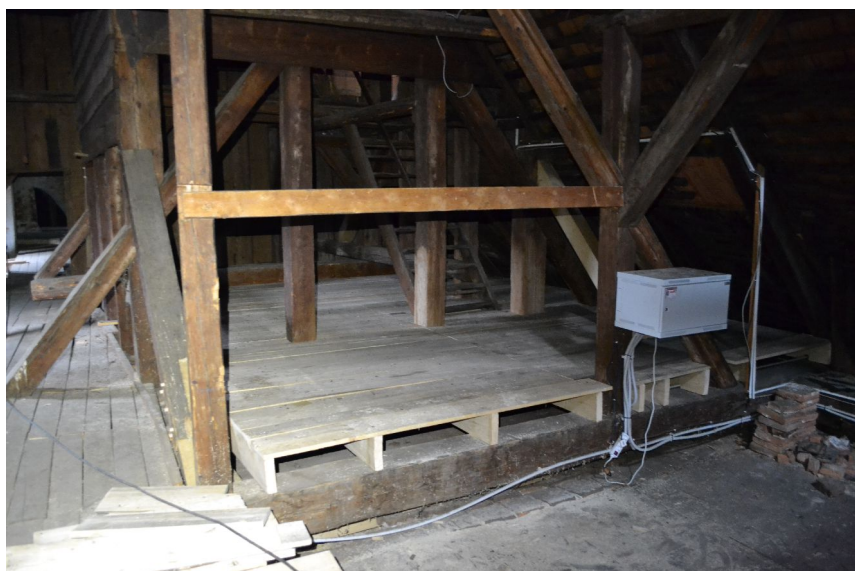
Foto 6 Prostor pod věžními hodinami po instalaci podlahy.
