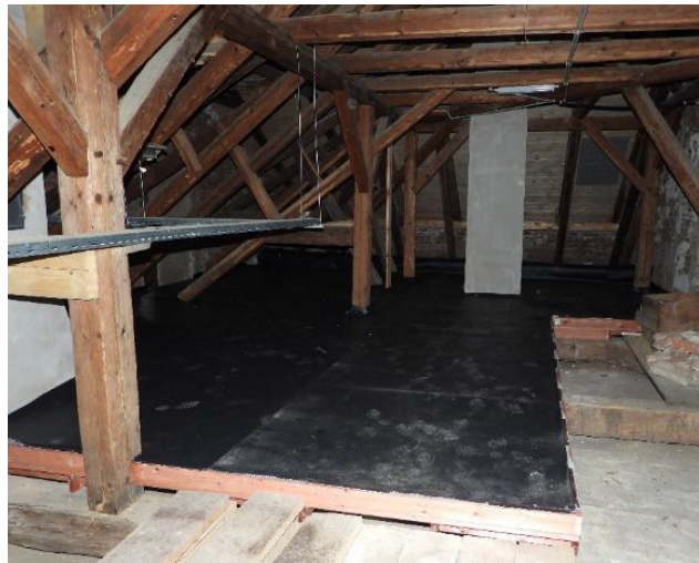
Foto 2 Podlážka již zakrytá hydroizolační fólií.
