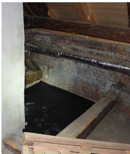
Photo 3 Mobilní podlážka zhotovená z geomříže překryté opět hydroizolační fólií, aby byla snadno přemístitelná.
