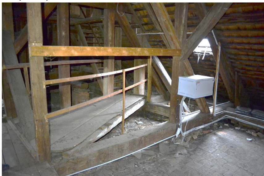
Foto 5 Prostor pod věžními hodinami před instalací podlahy.
